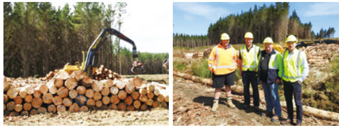
修建基础设施现场
